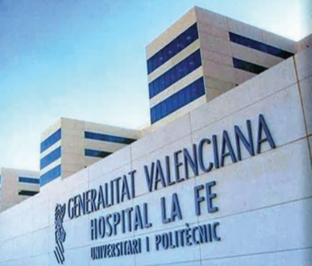
Nuevo Hospital de la Fe Montaje y mantenimiento de 78 ascensores y 2 escaleras mecánicas.
